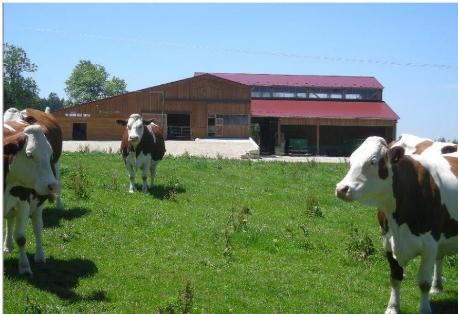
Le bâtiment est d'une superficie de 1530 m<sup>2</sup> et comporte 63 places en logettes paillées et une salle de traite de 2x7 postes en simple équipement, une fumière couverte de 240 m<sup>2</sup>.
