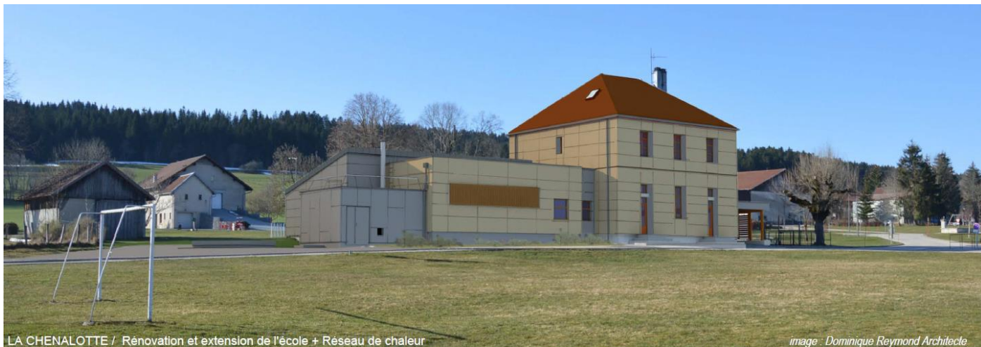
LA CHENALOTTE / Rénovation et extension de l'école + Réseau de chaleur
