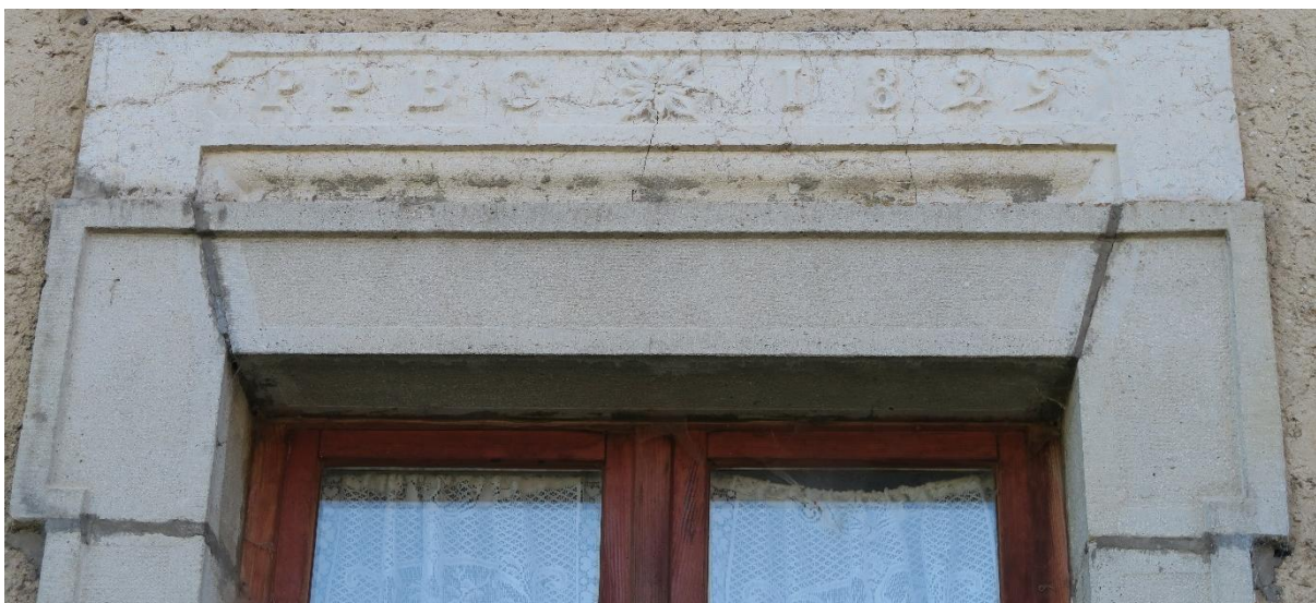
Figure 1 : Linteau de la fenêtre Est
